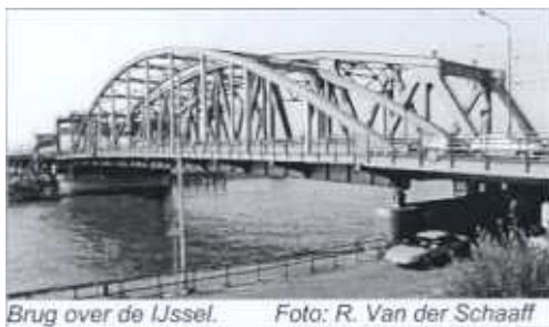
Brug over de IJssel. Foto: R. Van der Schaaff
